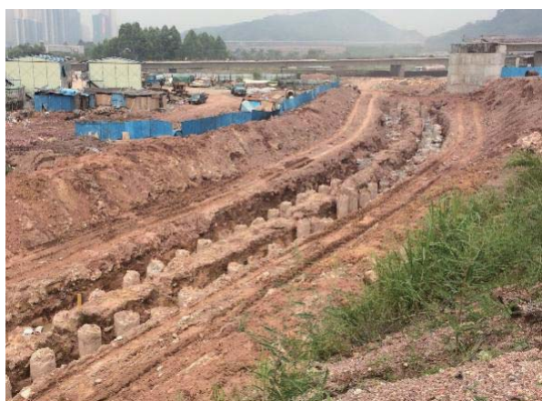
图 7: 旋挖灌注桩施工
