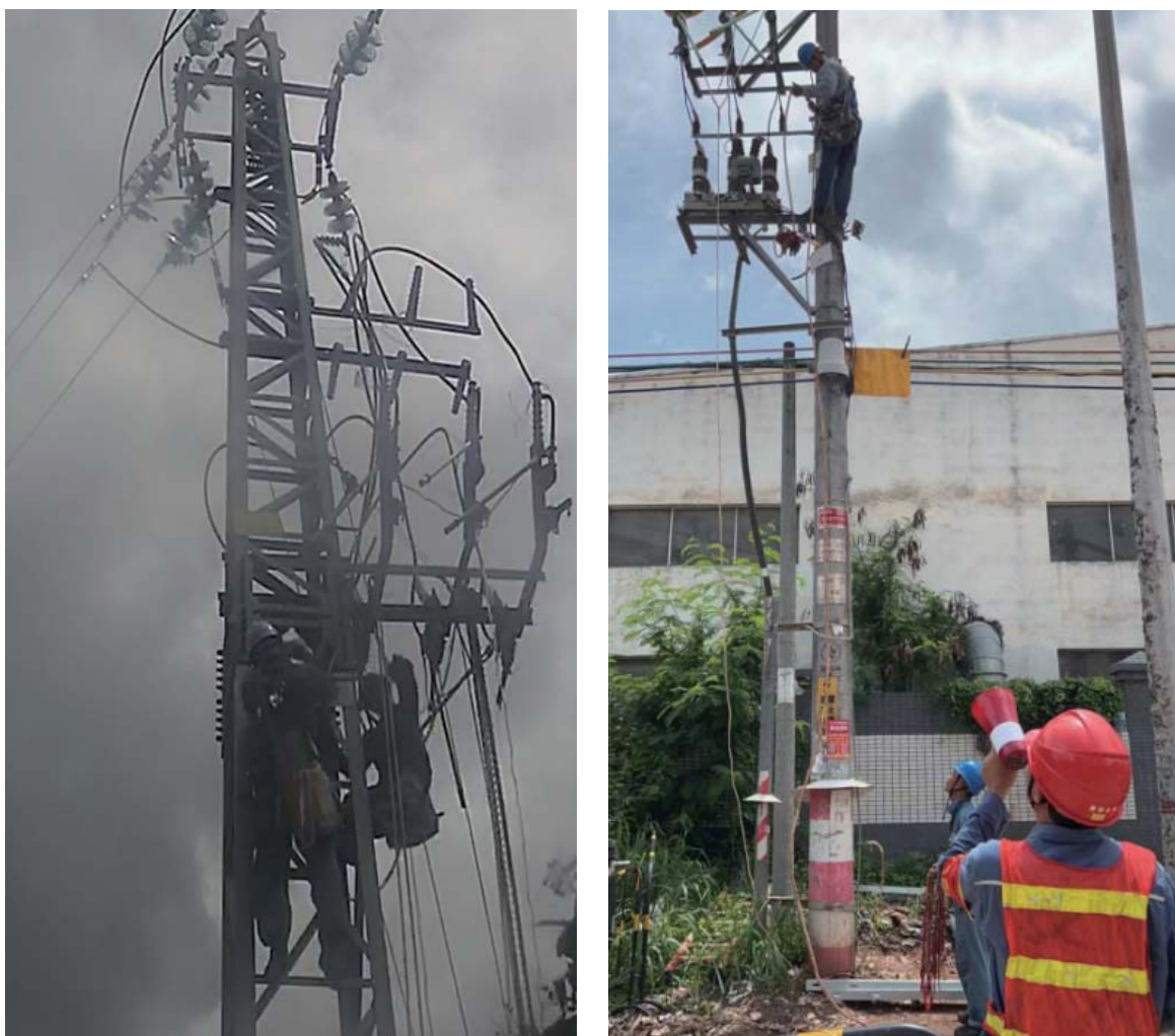
图11 增设“小喇叭”提醒上下杆塔“一步一扣”
