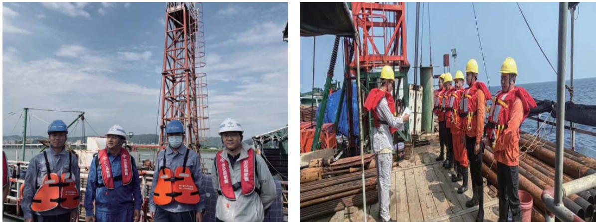
图2 开工前工程公司联合安全检查与每日站班会安全宣讲
