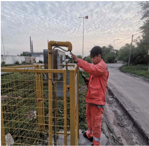
安装完成现场图示
